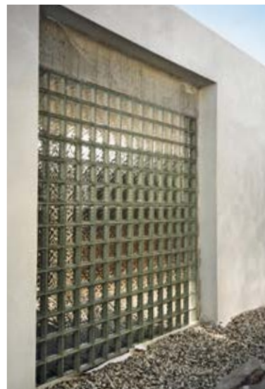
^ In questo cantiere [Palestra Comunale - Mussolente VI] abbiamo realizzato i Gradoni prefabbricati, le scale esterne di accesso alle tribune, i pannelli di tamponamento a taglio termico e le vetrate costruite con pareti prefabbricate in "vetromattone"
