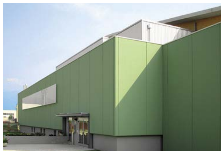
^ In questo cantiere [Palestra Comunale - Mussolente VI] abbiamo realizzato i Gradoni prefabbricati, le scale esterne di accesso alle tribune, i pannelli di tamponamento a taglio termico e le vetrate costruite con pareti prefabbricate in "vetromattone"
